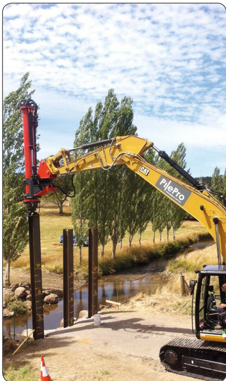
Проверка отказа погруженных двутавров, Австралия
