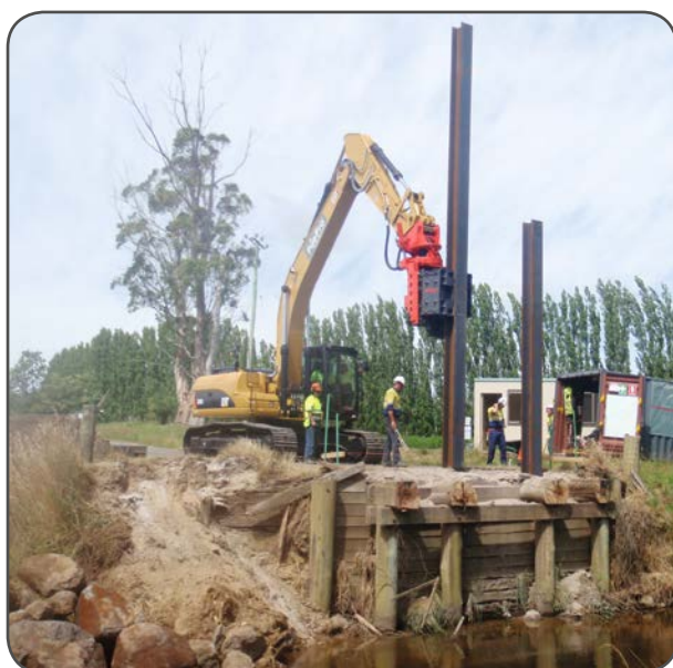
Погружение двутавровых балок, Австралия
