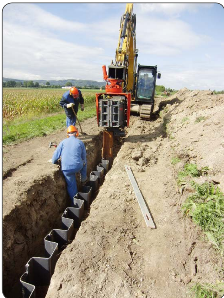
Погружение пластикового шпунта, Противофильтрационный экран, Австрия
