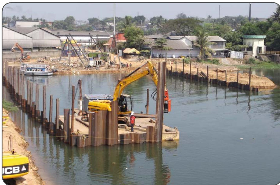
Шпунтовые работы, Индия
