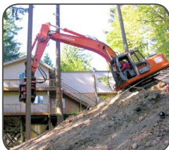
Шпунтовые работы, США
