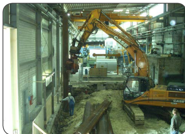
Шпунтовые работы внутри помещений, Германия
