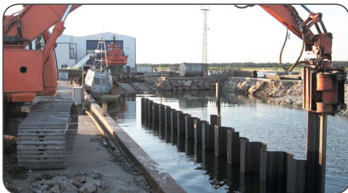
Шпунтовые работы, Эстония
