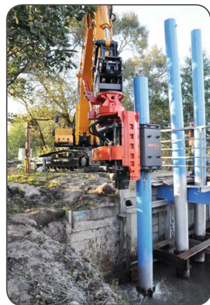
Трубчатые стальные сваи, Польша
