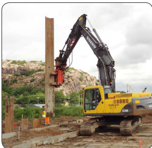
Шпунтовые работы, Швеция
