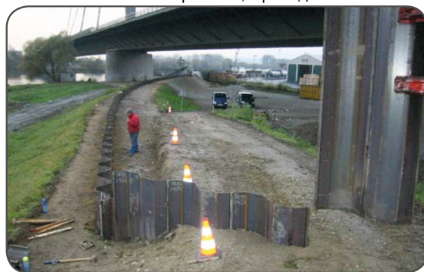
Шпунтовые работы, Германия
