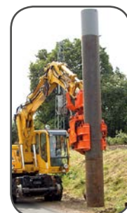
Фундаменты опор Германия
