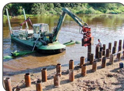
Трубчатые стальные сваи, Россия
