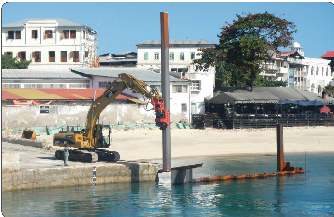
Погружение шпунтовых свай, Порт Занзибар, Танзания
