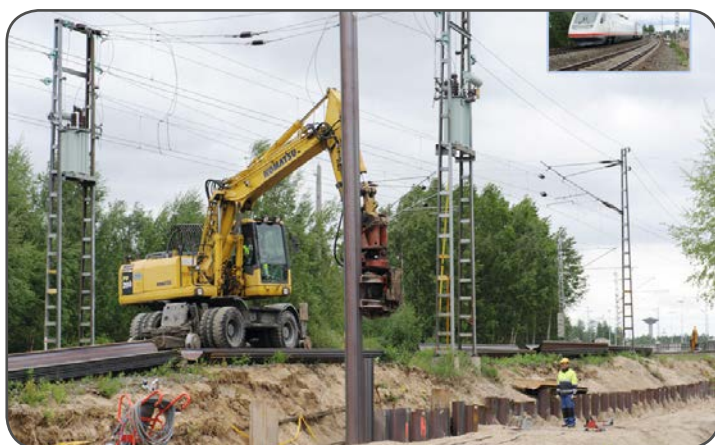
Шпунтовые работы, Финляндия
