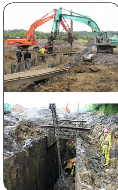
Шпунтовое ограждение траншей, Ирландия
